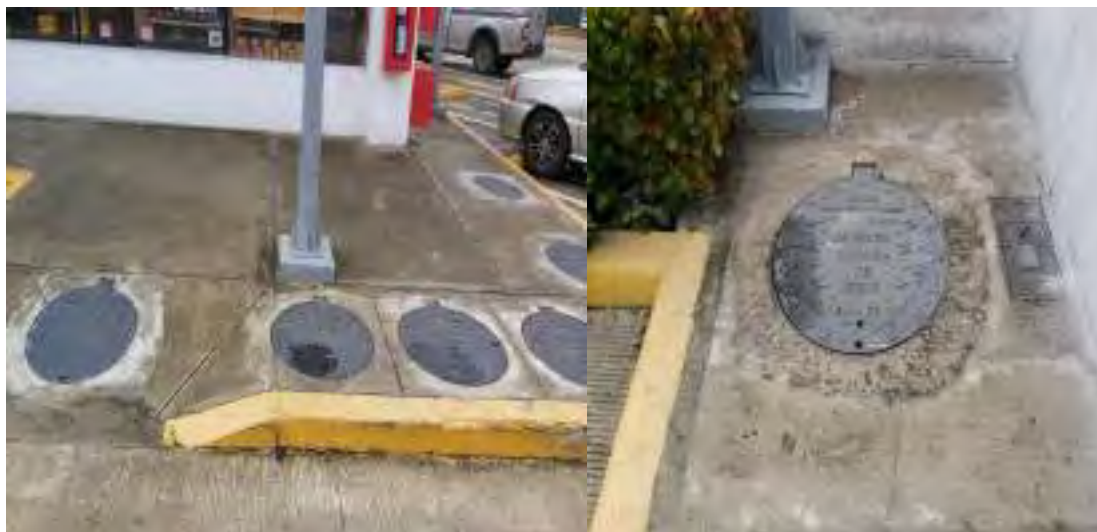
Ilustración 3.13. Trampa de grasas y alcantarillado
