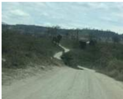
Fotografía Vías acceso al proyecto
