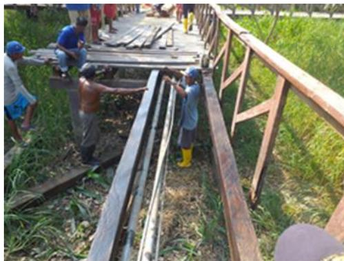
**Ilustración 1** Trabajos de reconstrucción de camineras en Isla Santay previo a la reapertura del área protegida
